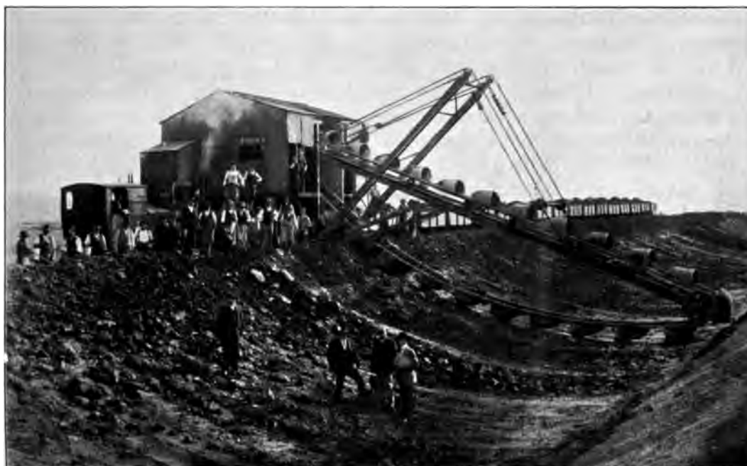
Figur 4. Baggermaschine im Fünfstetter Einschnitt.
